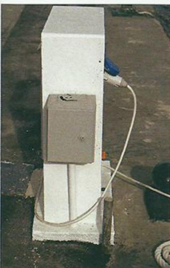
Una o varias vueltas del cable al punto de conexión o a un noray evitarán que la línea se desconecte por un tirón o por movimiento excesivo del barco.
